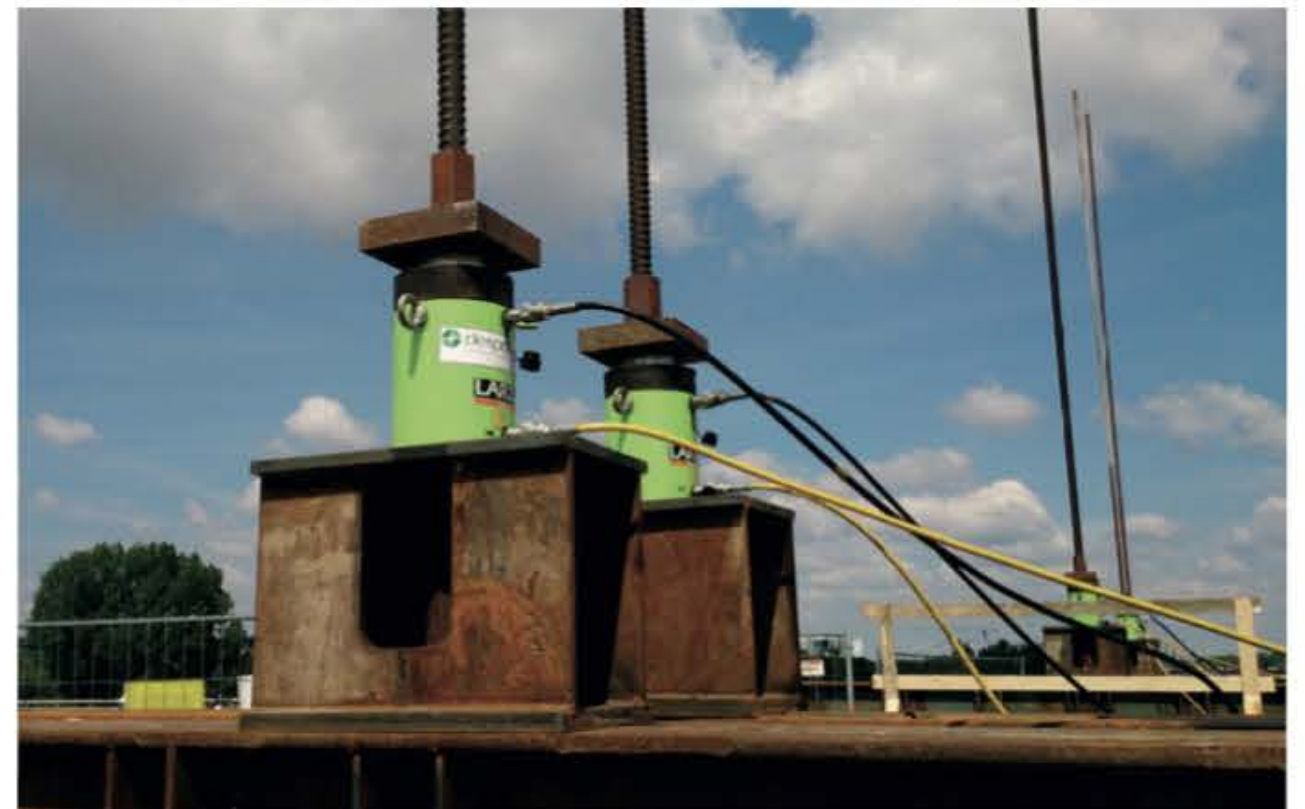
Podnoszenie elementów konstrukcyjnych mostu
