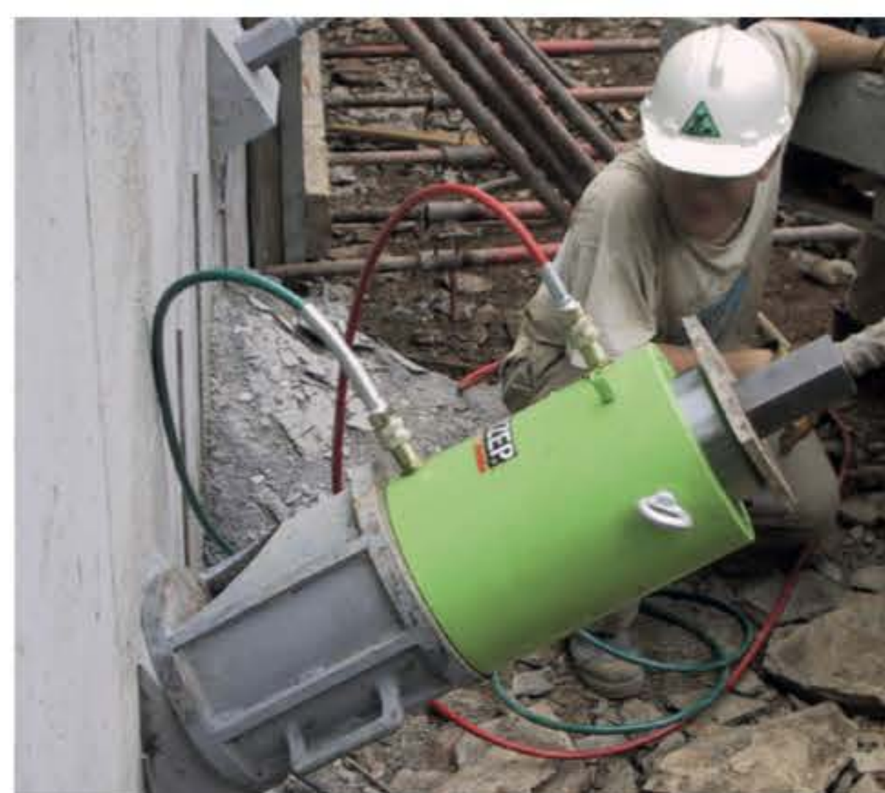
Napinanie prętów systemu Diwidag przy zastosowaniu siłowników LARZEP z otworem przelotowym
